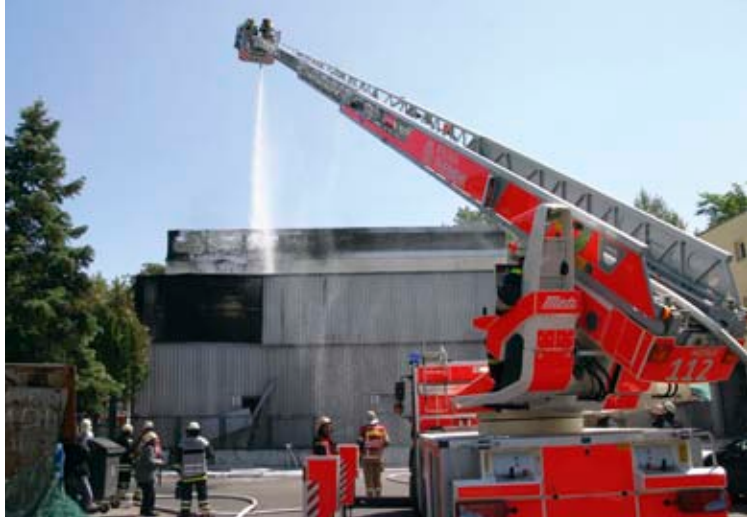
ENERGIEÜBERSCHUSS IN NEUKÖLLN Trafoexplosion am 24. Juni
