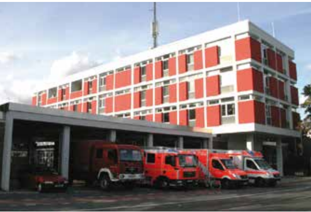
SANIERUNGSSTAUFREI IN FÜNF JAHREN Im Jahr 2012 fertig sanierte FW Buckow
