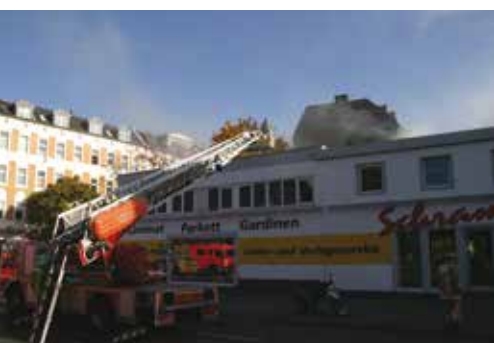
ALLES UNTER KONTROLLE? Noch deutet nichts auf die Durchzündung hin
