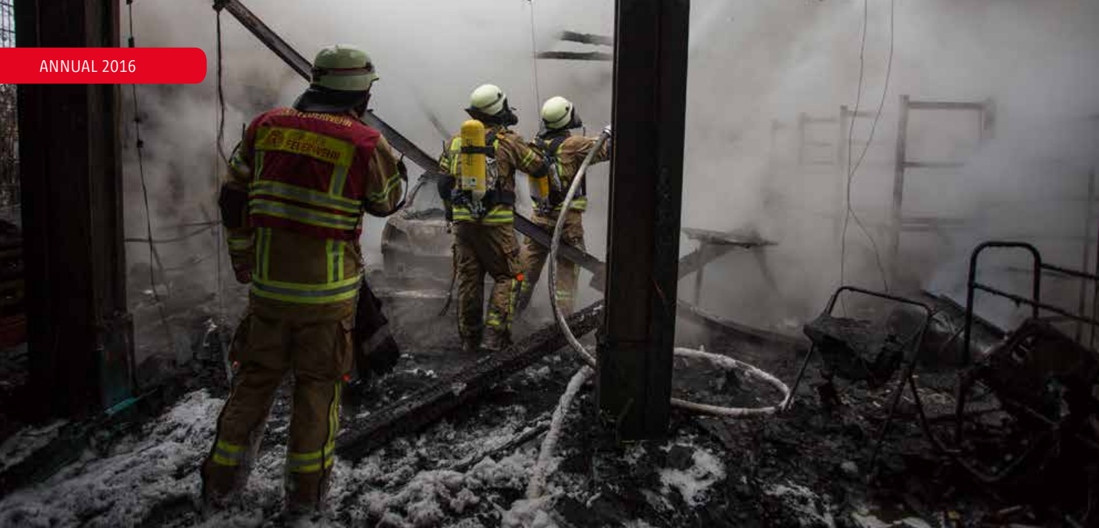
EINSATZKRÄFTE IN EINER AUSGEBRANNTEN WERKSTATT
