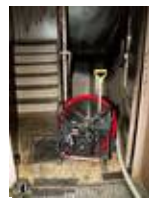
Belüftung mit Drucklüfter
