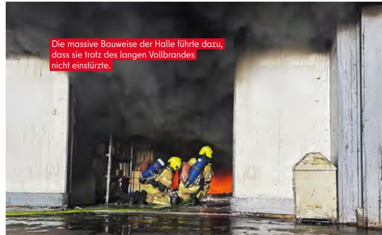
Die massive Bauweise der Halle führte dazu, dass sie trotz des langen Vollbrandes nicht einstürzte.
