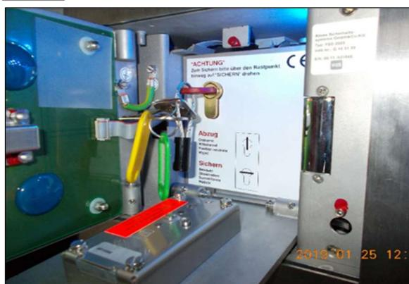
Beim Öffnen des FSD 3 befindet sich der Schlüssel in der Stellung „Sichern“. Erst bei der Schlüsselstellung „Abzug“ können Schlüssel entnommen werden. Damit das FSD 3 (nach dem Einsatz) verriegelt, muss der Schlüssel auf Stellung „Sichern“ stehen und die Schlüsselplombe in Richtung „Sichern“ gelegt werden.
