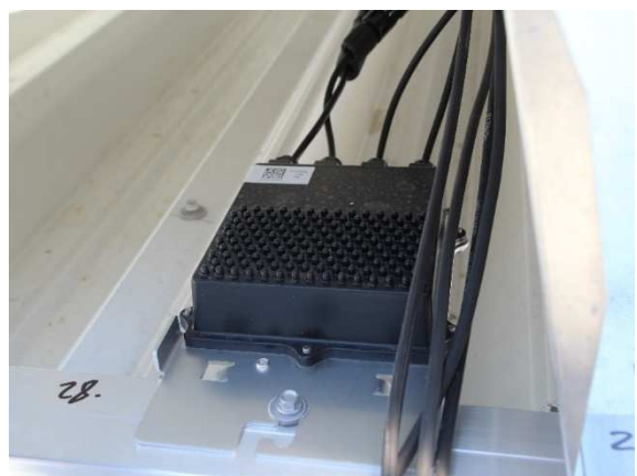
Abbildung 5: „Leistungsoptimierer“, welcher direkt am Modul die DC-Leitung spannungslos schaltet.
